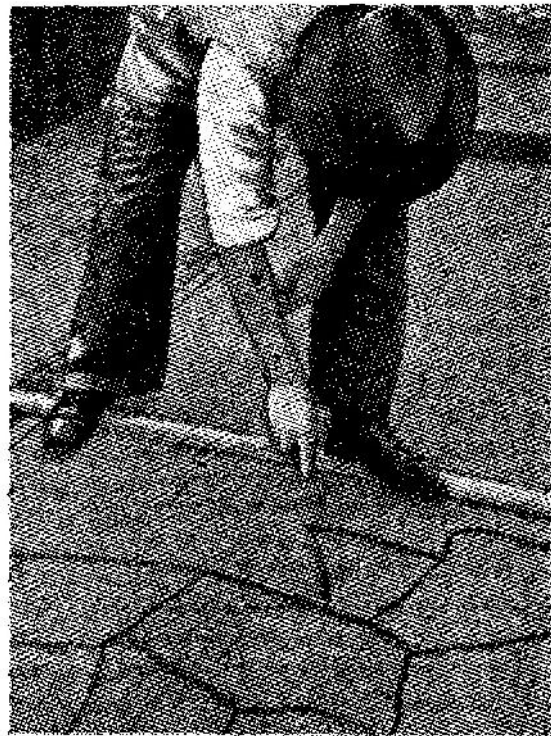
Las piezas se cortan con una llana.
