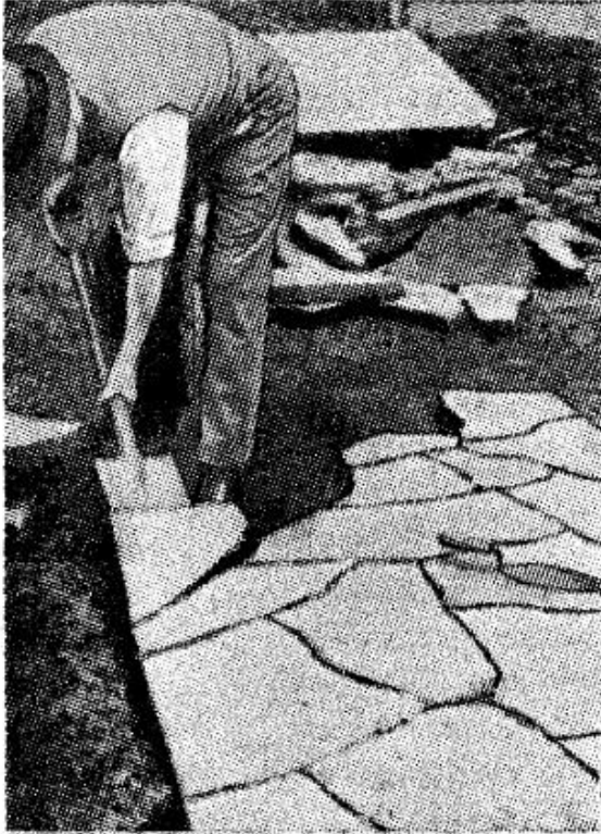
Las piezas se levantan con una azada.
