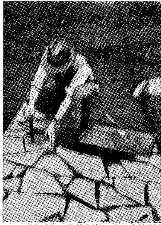
Colocación de las piezas.
